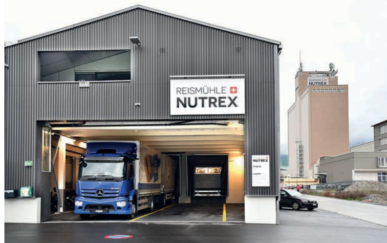
Am Standort in Brunnen hat der Detailhändler Coop die grösste Reis- und die Essigproduktion der Schweiz zusammengelegt, Foto © Steinegger
