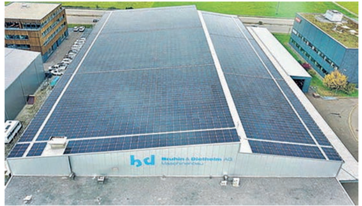
Die Photovoltaik-Anlage von Bruhin & Diethelm ist eine der grössten im Kanton Schwyz. Es sollen 910 000 kWh Strom pro Jahr produziert werden.
