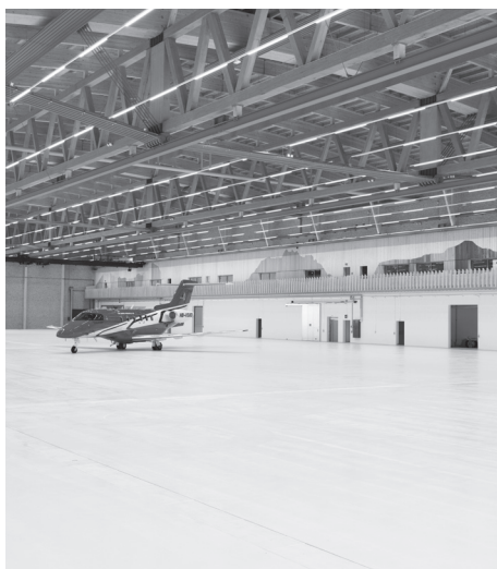
Montagehalle Pilatus Flugzeugwerke AG, Stans NW
