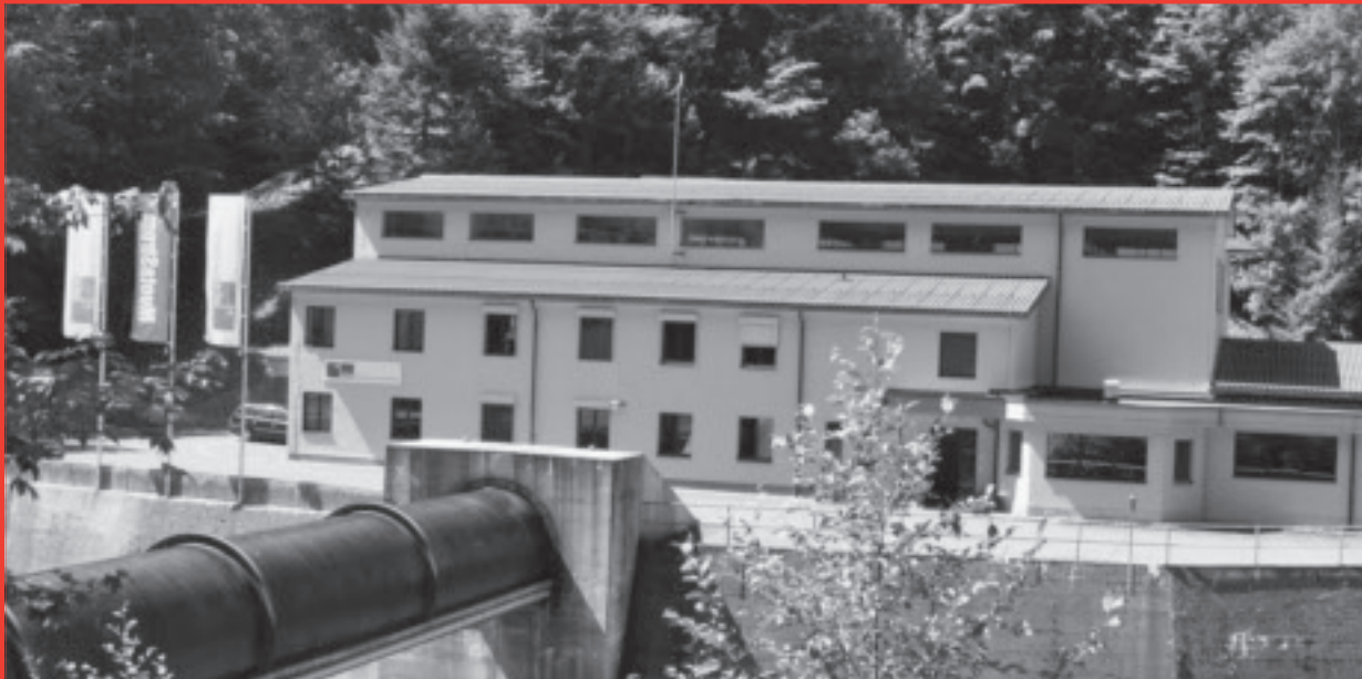
Elektrizitätswerk des Bezirks Schwyz
