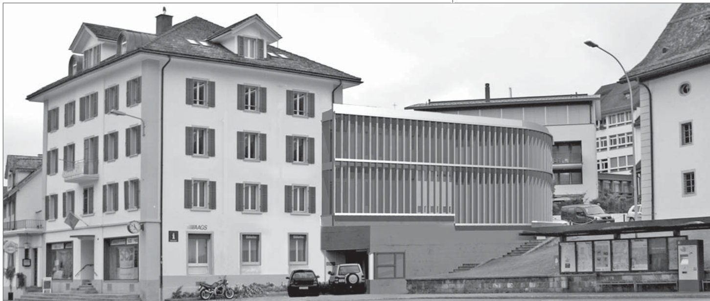
Der Sitz der pensionskasse pro in Schwyz mit neuem Anbau
