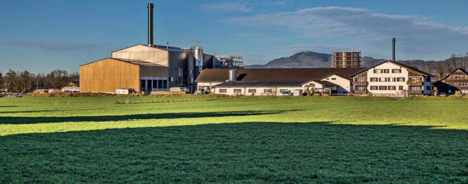
Energiezentrum Ausserschwyz Foto © :Axel-B. :Bott
