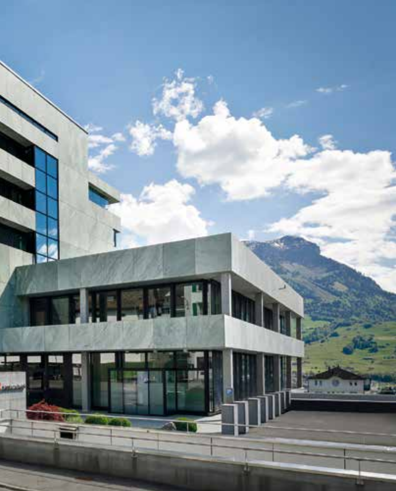
Hauptsitz der Schwyzer Kantonalbank in Schwyz.
