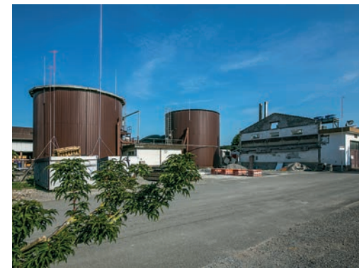
Biogasanlage Züger, Galgenen
