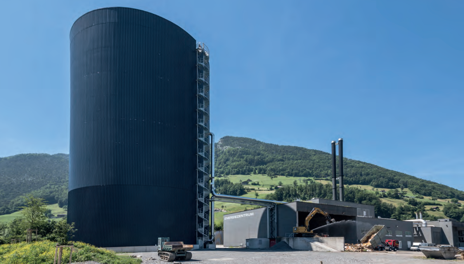
Der Warmwasserspeicher (95°) bietet mit 28'000 m 3 Wasser eine Vollversorgungsreserve von 2 Tagen (650 000 kWh). Fotos © :Bott
