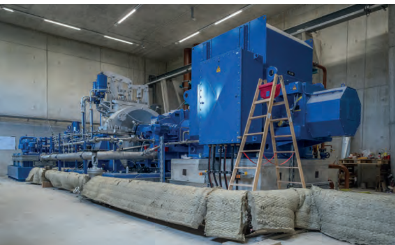
MAN - Dampfturbine, 5.5 MW, bei 420 ° und 60 bar
