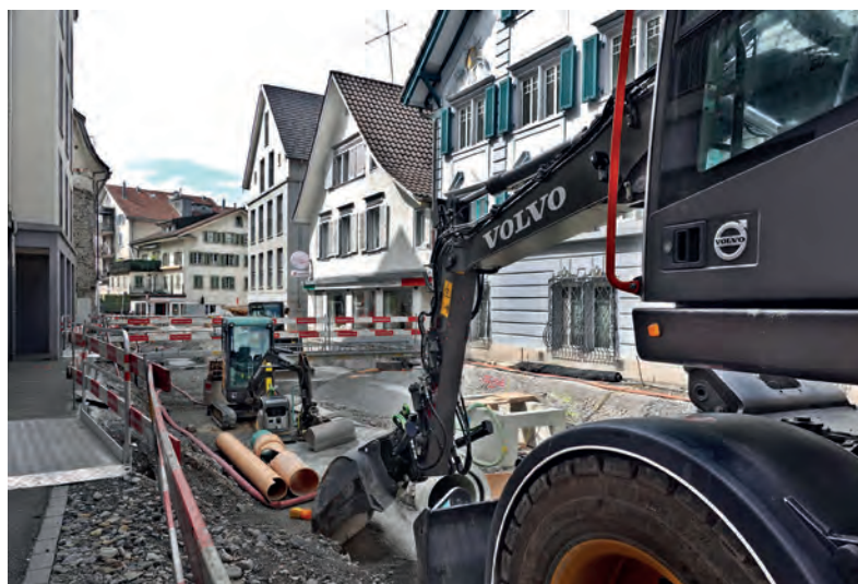
Zuleitungsbau Fernwärmeversorgung Lachen, Foto @ :Axel-B. :Bott
